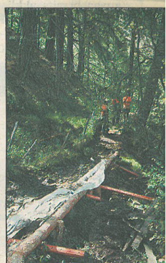
Weite Strecken mussten vor dem Wegbau trockengelegt werden.
