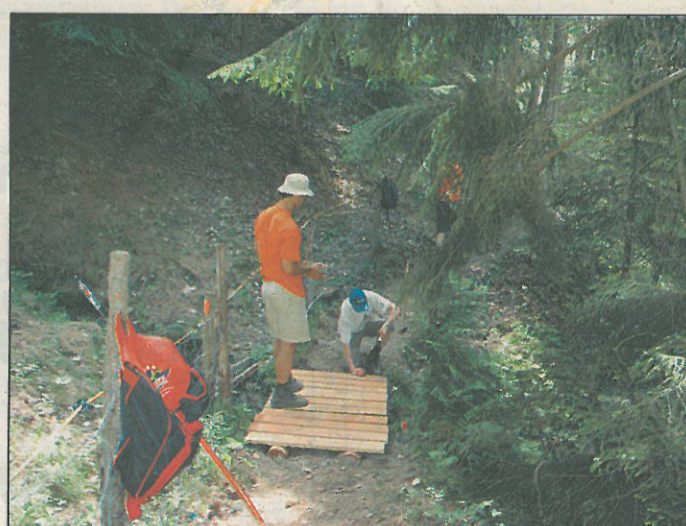
Kleine Stege sorgen dafür, dass der Weg trocken und bequem bewandert werden kann.
