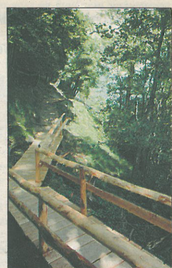
Holzbrücke mit seitlichen Geländern zur Sicherheit.
